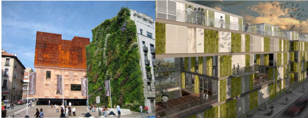
Figura 4. Fachadas verdes(Fuente: Izq. Caixa Forum, Madrid, P. Blanc, 2007.Dcha: Viviendas San Jose, Murcia, E. Mínguez, 2009)
