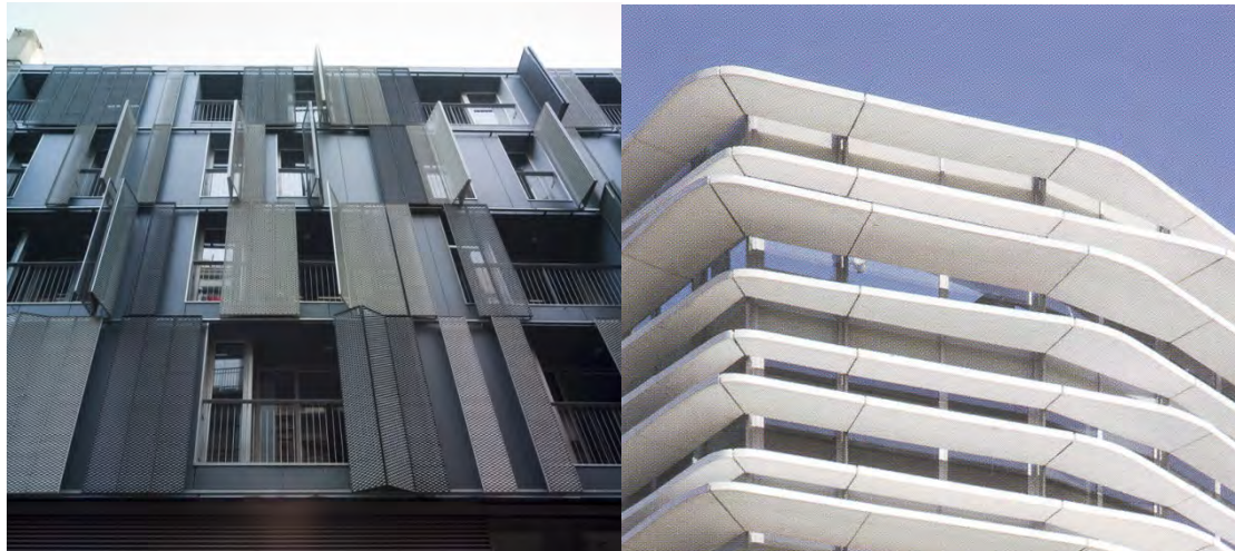
Figura 1. Lamas móviles y Aleros en edificio de Oficinas en la M-30. (Fuente: Buenas practicas en Arquitectura y Urbanismo para Madrid)
