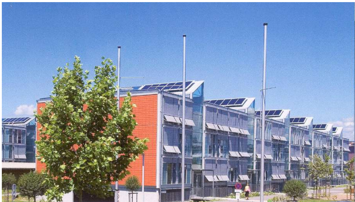
Figura 15. Bloque residencial. (Fuente: Herzog, 2005)
